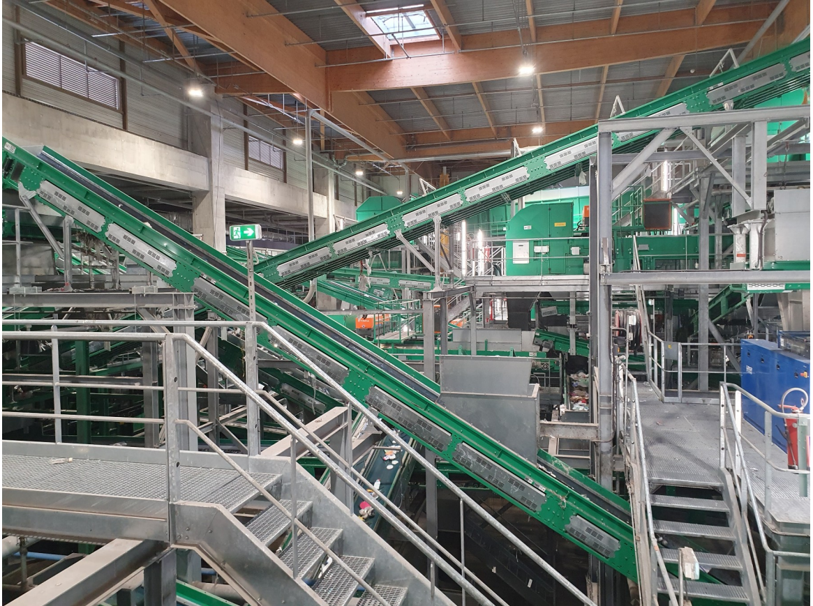
Vue générale de l'usine
